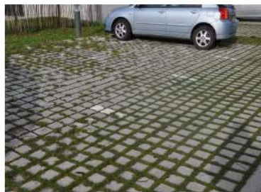
Photo 4 : Sol semi imperméable
