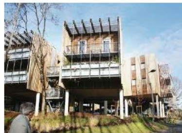
Photo 5 : Logements semi collectifs
