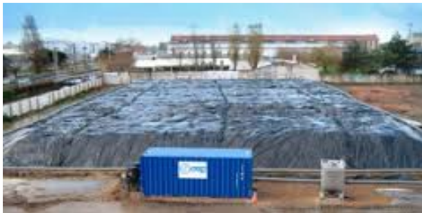
Traitement des sols sur site
