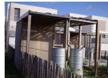
Photo 6 : Récupération eau de pluie
