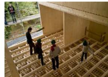
Photo 6 : Construction en bois
