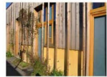
Photo 7 : Construction en bois
