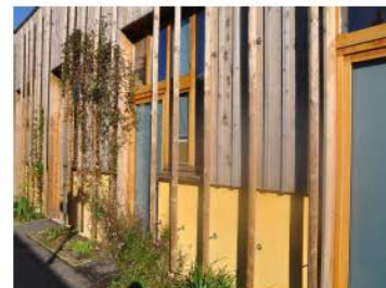
Photo 7 : Construction en bois
