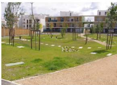
Photo 1 : Bassin de rétention intégré
