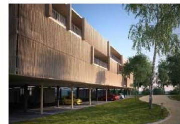
Photo 8 : Stationnement en rez de chaussée
