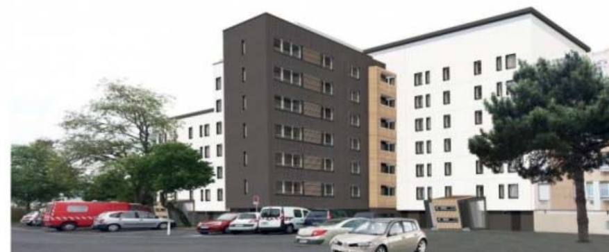
Projet de réhabilitation VLS 500 OPH – 64 logements – Début des travaux : 2017
