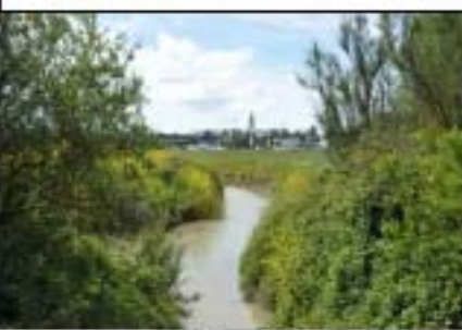
Bassin pluvial de Tasdon Ouest
