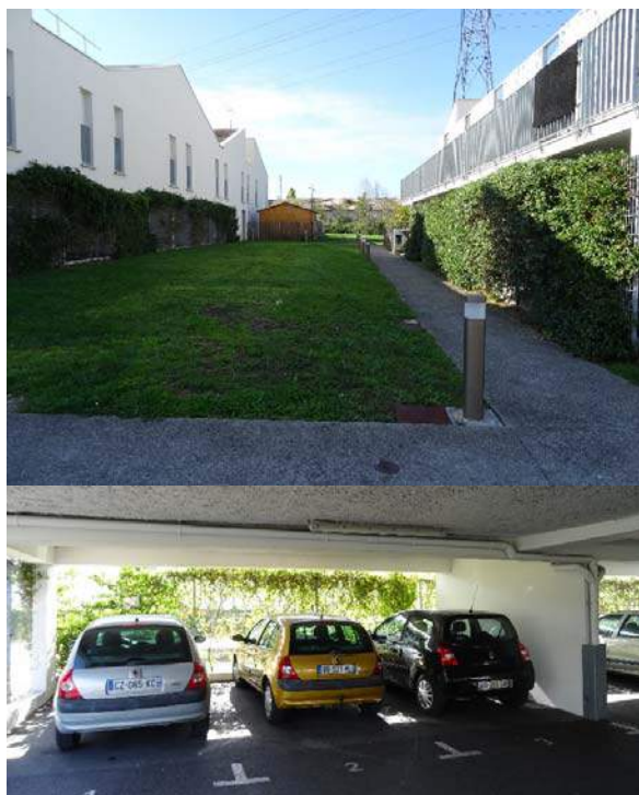
Exemple d'intégration du stationnement privé en rdc d'immeuble
