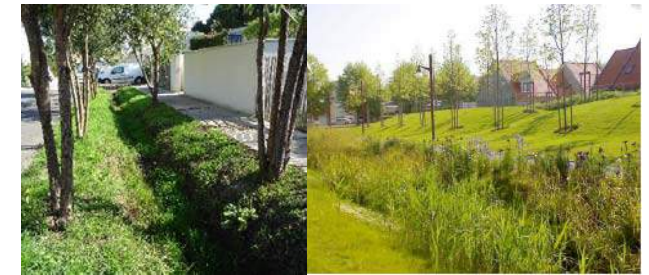
Gestion alternatives des eaux de pluies par des noues et l'utilisation de matériaux drainants = > création de paysages d'agrément
