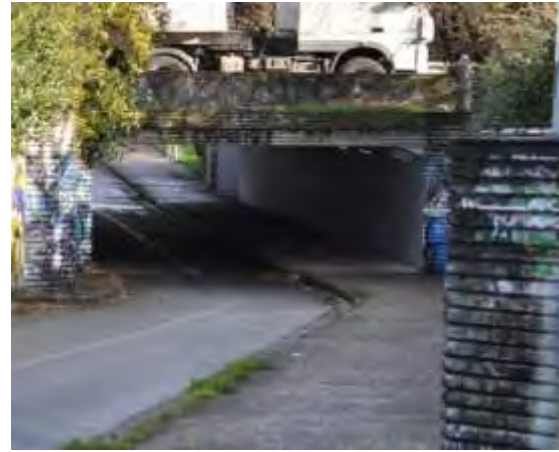
Passage sous la voie rapide, vers Beaulieu
