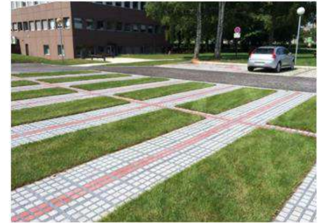
Dalles-pavées- Aulnoy-les- Valenciennes (59)
