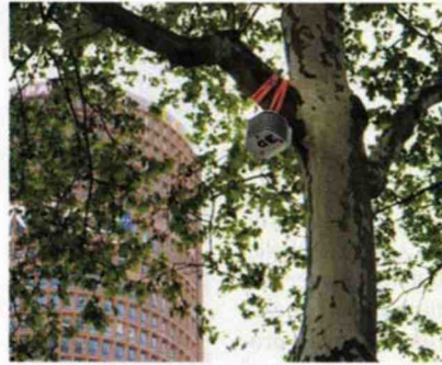
Les capteurs sont reliés à la sonde d'un bassin de récupération des eaux pluviales.
