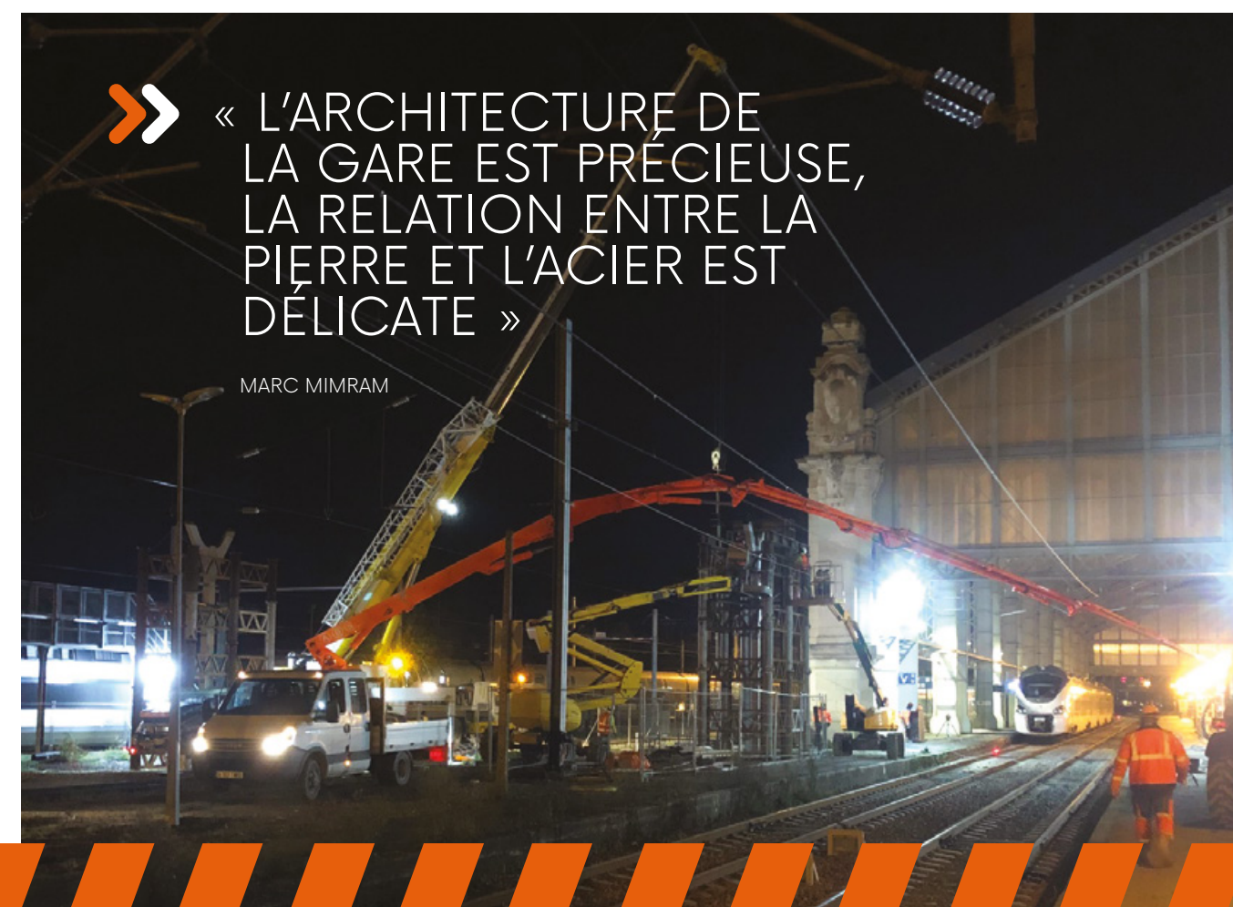
Forage des micro-pieux de la passerelle
