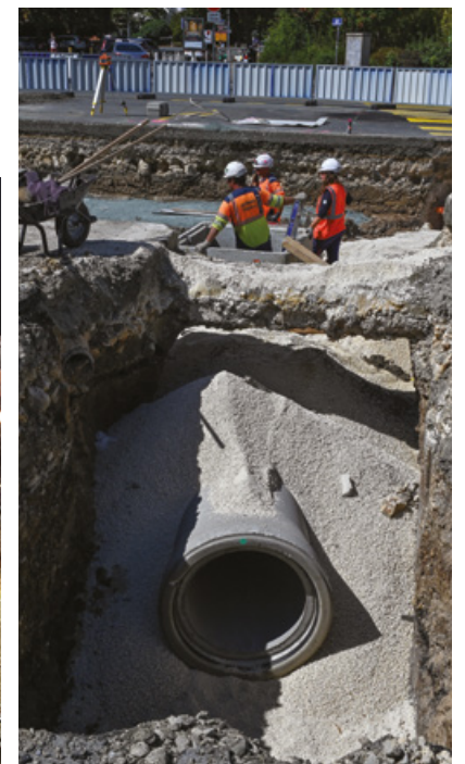
Installation des canalisations sur le parvis
