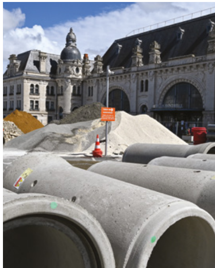
Travaux d'assainissement sur le parvis
