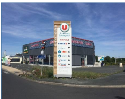
Préenseigne scellée au sol type Totem
