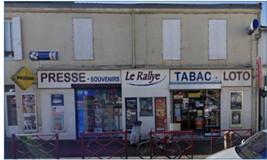
Enseignes sur façades et en drapeau
